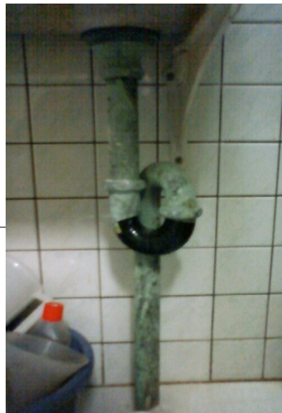
現場の状況も 写真にして送ればわかりやすい
