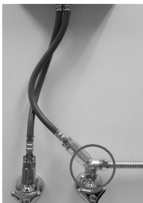
混合栓配管の負荷を低減する継手です。混合栓を食器洗浄機などに分岐するさいフレッドホースが固く曲げにくくなっているためホースが座屈するなどの問題がありました。この継手を利用してすることでホースを湾曲させて接続することにより座屈が起きないようにし漏水リスクを減らすことができます。
