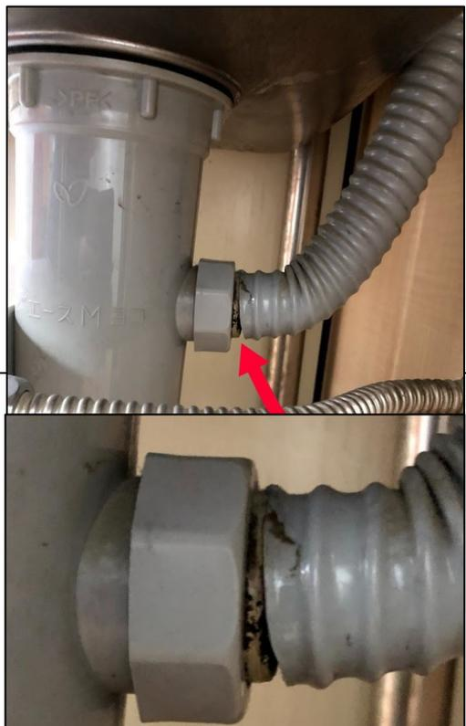
そんなわけで、事務所の流し台の排水部が、少し前から水漏れしていたので自分で修理することにしました。矢印のところから水が漏れてしまっています。
